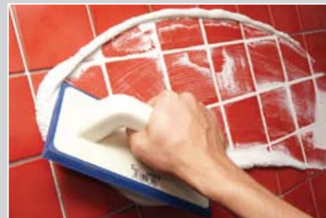
Нанесение LITOSCHROM 1-6 резиновым шпателем
